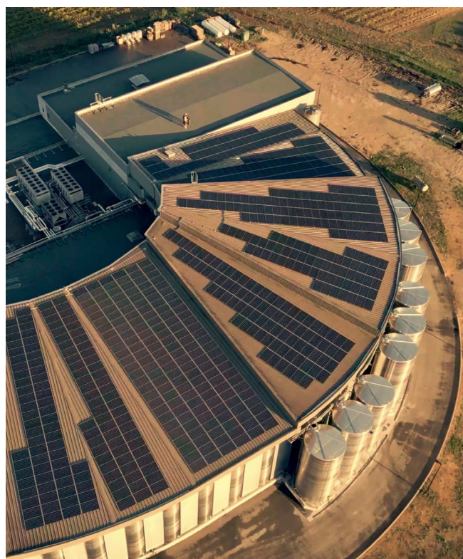
▶ Centrale photovoltaïque citoyenne de la cave Héraclès à Codognan (30) ©ACCTE
