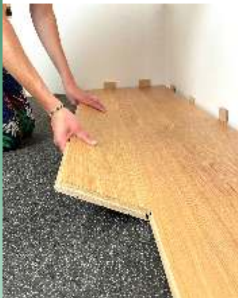
Naofloor se pose sur une sous-couche et ne nécessite aucun outil, son système d'emboîtement breveté lui assure une stabilité parfaite.
