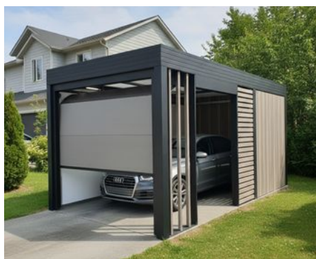
Carport avec porte de garage et local technique
