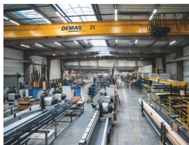
Site industriel d'Alu-Glass à Poilley
