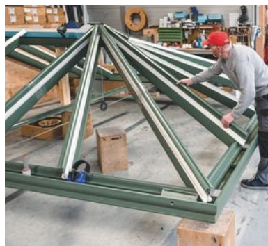
Prémontage d'une toiture de véranda
