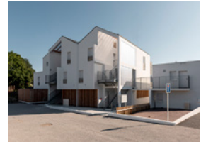
© Richard Faure architectes
