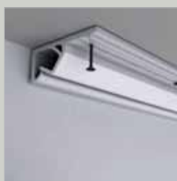
Pose d'un profilé en périphérie
