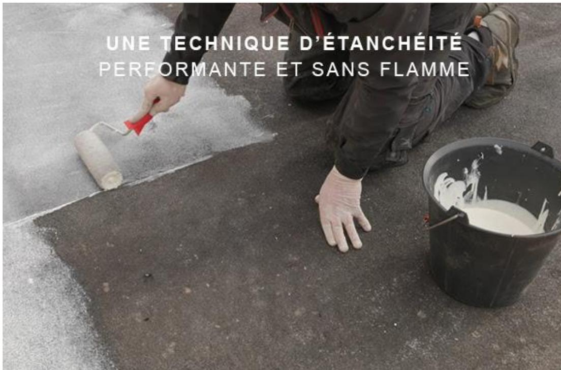
Contrairement aux techniques traditionnelles nécessitant des joints, des soudures ou l'utilisation de flammes, **ETANX** propose une approche plus facile et pratique de mise en œuvre. La technique d'étanchéité liquide, qui consiste en l'application de résines en une ou plusieurs strates, garantit une imperméabilité optimale, tant sur des supports neufs que pour la rénovation.
