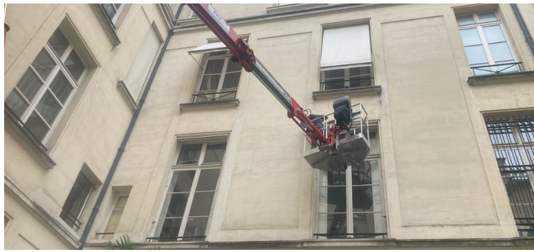
Utilisation d'une nacelle motorisée pour installer des stores extérieurs à projection sur la façade d'un bâtiment
