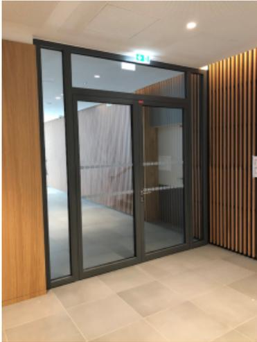
B2 : Cloison vitrée 2 vantaux de 2,83 m x 3 m de hauteur.
