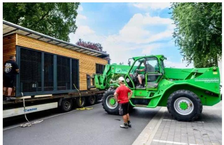
Pour ce bâtiment, un module composé de 4 pompes à chaleur Daikin 3 H HT d'une puissance de 50.7 kW et de ballons d'eau chaude sanitaire à production centralisée (eau chaude et eau froide grâce au système Daikin ECH2O) a été commandé.
