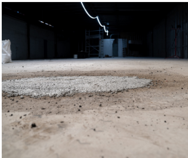
© Watco® - nivellement des surfaces en béton endommagées.
