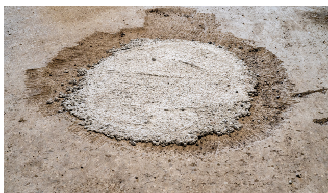
© Watco® - Mortier Coulable de réparation de Watco® appliqué pour combler les irrégularités et les trous.
