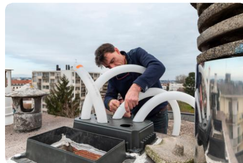
Chantier Rolux Multiflex en copropriété - Bayonne - Entreprise R'Pur
