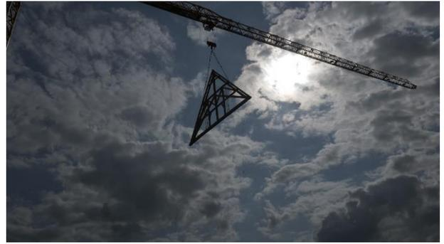
**Visuel 24 (30 août 2023)** Dans le ciel, une ferme de la charpente du grand comble est grutée depuis la plateforme d'assemblage jusqu'aux murs de la cathédrale. © **Rebâtir Notre-Dame de Paris**
