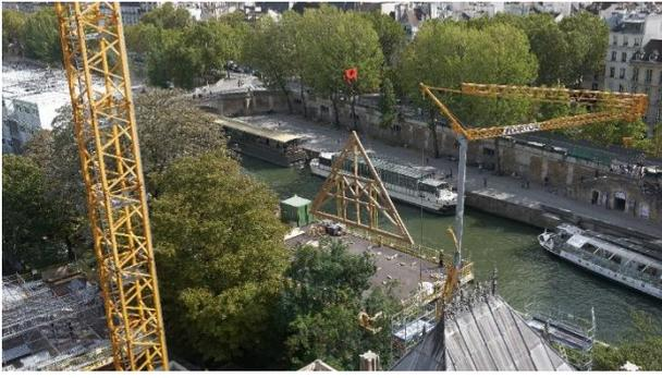
**Visuel 23 (30 août 2023)** Les fermes de la charpente du grand comble sont grutées depuis les plateformes d'assemblage au bord de la Seine jusqu'aux murs de la cathédrale. © **Rebâtir Notre-Dame de Paris**
