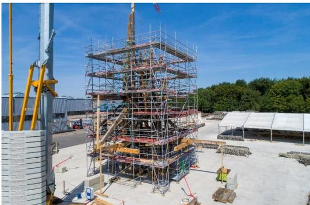
**Visuel 9 (20 juillet 2023)** Avant son arrivée sur le chantier, le fût de la flèche est monté à blanc par les charpentiers, en Lorraine. Il a ainsi été assemblé grandeur nature pour vérifier qu'il est conforme aux prescriptions des architectes. Il a ensuite été démonté pour être acheminé jusqu'à la cathédrale, où il est remonté. **David Bordes © Rebâtir Notre-Dame de Paris**
