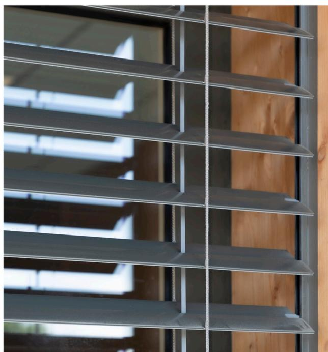
Les lames en forme de Z offrent une maîtrise fine et constante de la lumière naturelle entrante. Les lames orientables, fabriquées en aluminium et équipées de joints en néoprène, garantissent une obscurité totale lorsqu'elles sont fermées.
