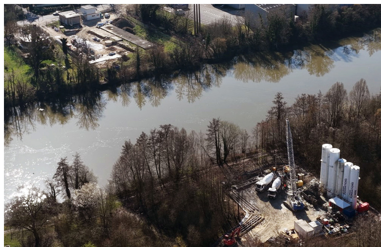
Puits de départ et de sortie pour le franchissement sous l'Oise du microtunnelier
