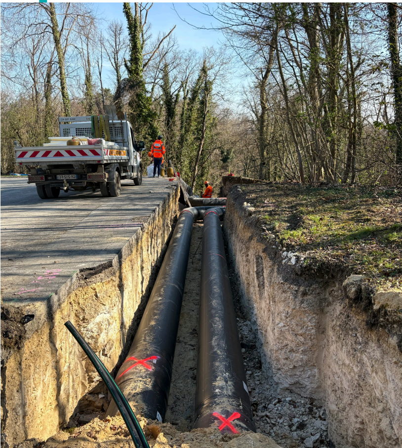
Enfouissement des canalisations
