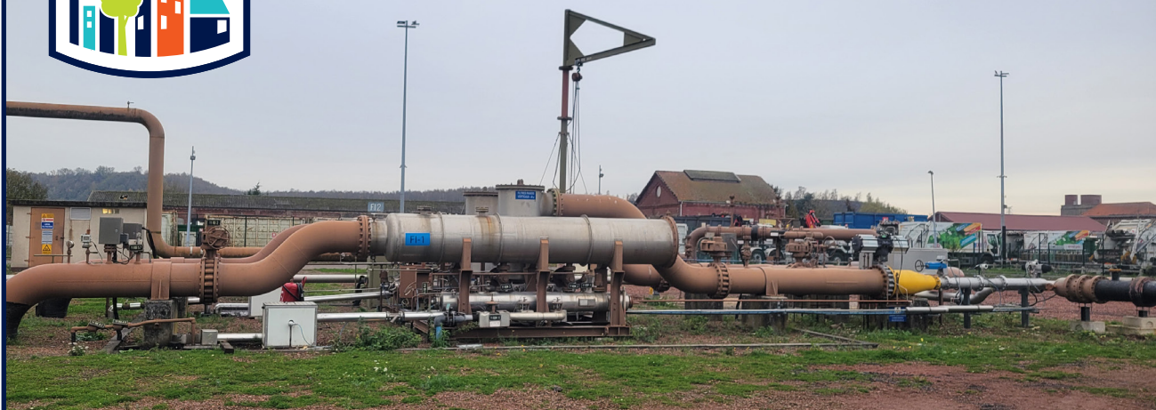
Site de captage de chaleur du réseau d'Avion (puits minier)
