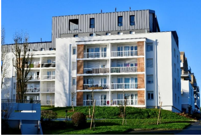
Renouvellement urbain du Trieux, Saint-Malo (35) - Photo © Realflex Thierry Dourdet
