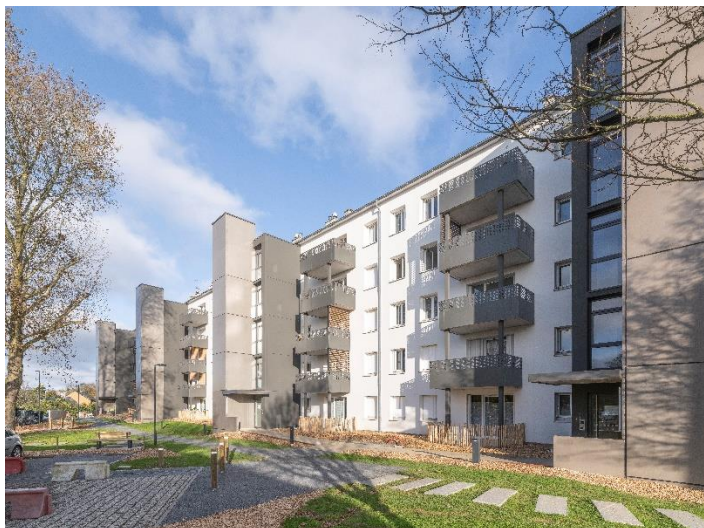
Réhabilitation La Perrière, Laval (53) – Photo © Dimitri LAMOUR
