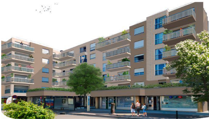
Projet de réhabilitation énergétique de 148 logements, Le Chesnay-Rocquencourt (78) - ©TOIT ET JOIE – POSTE HABITAT
