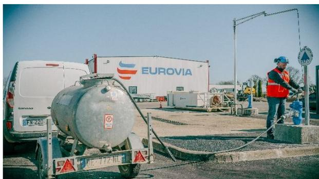
*Remplissage d'une cuve en eau pluviale récupérée et filtrée pour les besoins d'un chantier*
