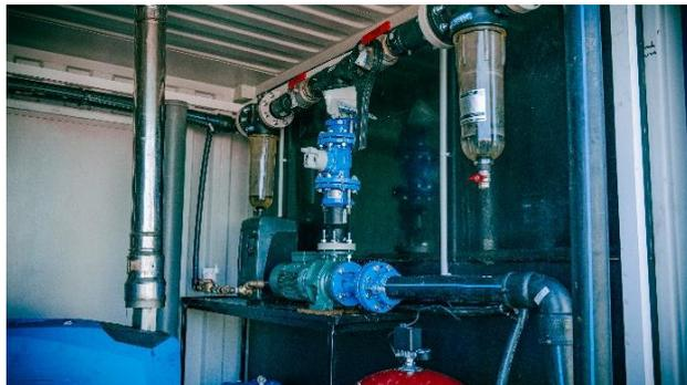
*Systeme de pompe et de filtration des eaux pluviales récupérées*
