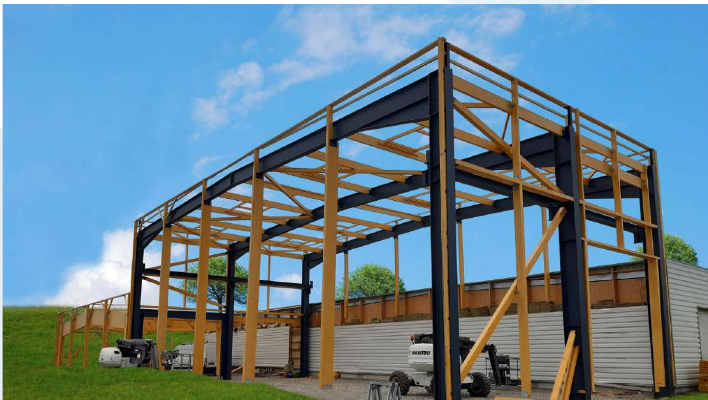
Réalisation charpente mixte bois/métal - Entreprise Deschamps
