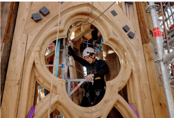
Visuel 43 (21 novembre 2023) Les charpentiers ont posé les premiers éléments de décors en bois sur l'ossature de la flèche. Ils seront par la suite recouverts de plomb martelé. © Patrick Zachmann / Magnum Photos – Utilisation soumise à conditions
