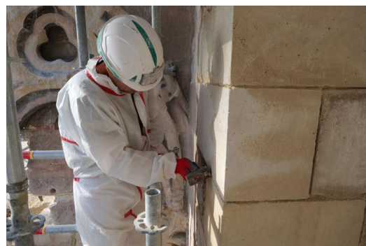
Visuel 10 (1 er décembre 2023) Démonté puis remonté pierre par pierre, les tailleurs de pierre ont achevé le remontage du pignon ouest.
