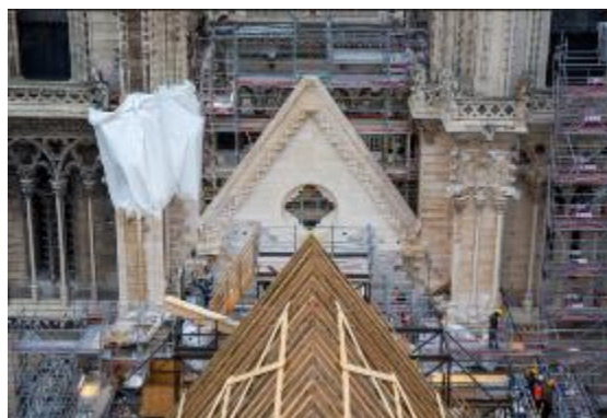
Visuel 6 (1 er décembre 2023) Endommagés par l'incendie, le pignon ouest a été démonté puis remonté pierre par pierre. Sa restauration est aujourd'hui achevée.
