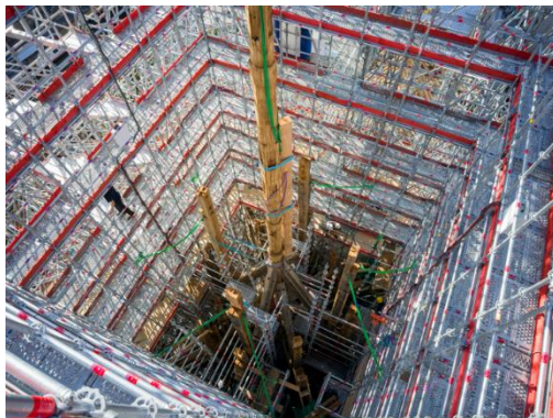
Visuel 36 (27 octobre 2023) Le poinçon, épine dorsale de l'ouvrage est entouré des poteaux arêtiers qui forment l'ossature extérieure de la flèche.
