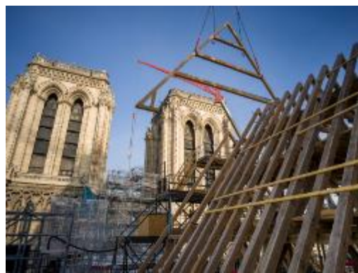
Visuel 20 (25 octobre 2023) Les charpentiers et les grutiers posent la ferme n°7. Chaque ferme adopte un dessin unique, fidèle à celui qu'avait au Moyen Age celle qu'elle remplace. David Bordes © Rebâtir Notre-Dame de Paris
