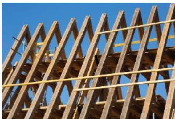
Visuel 19 (25 octobre 2023) Les charpentiers montent une à une les travées de la charpente en chêne nef et chœur, composées chacune de deux fermes principales et de quatre fermes secondaires, ou chevrons. David Bordes © Rebâtir Notre-Dame de Paris
