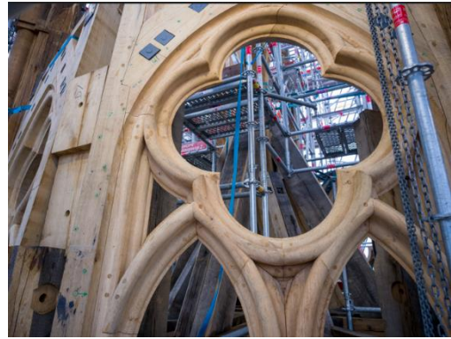
Visuel 42 (27 octobre 2023) Les charpentiers ont posé les premiers éléments de décors en bois, sculptés en ateliers avant d'être fixés aux poteaux arêtiers, qui forment l'ossature de la flèche. Ils seront par la suite recouverts de plomb martelé. David Bordes © Rebâtir Notre-Dame de Paris
