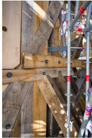
Visuel 34 (5 octobre 2023) Le poinçon, épine dorsale de l'ouvrage, est entouré des poteaux arêtiers qui forment l'ossature extérieure.
