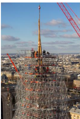
Visuel 50 (2 décembre 2023) Avec la pose de l'aiguille, dernier élément de charpente, une nouvelle étape est franchie dans la reconstruction de la flèche. David Bordes © Rebâtir Notre-Dame de Paris
