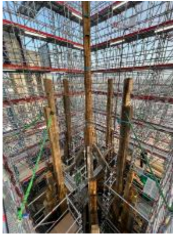
Visuel 33 (5 octobre 2023) Les charpentiers et les grutiers ont posé le poinçon, qui correspond à l'épine dorsale de la flèche.
