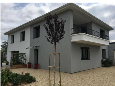
Projet d'isolation globale - remplacement de toutes les menuiseries, isolation par l'extérieur, pose de volets roulants.
