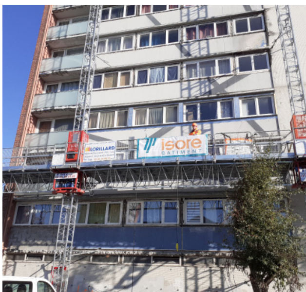
ISORE Bâtiment a fourni à Lorillard des nacelles sur mâts, facilitant l'accès et la mise en place des éléments sur les façades. © Lorillard
