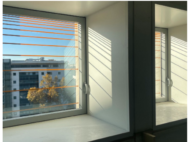
Les allèges existantes ont été confinées par une extension et un encoffrement de l'isolant, tandis que les tableaux ont bénéficié d'une finition en mélaminé blanc avec des cornières de finition. © Lorillard
