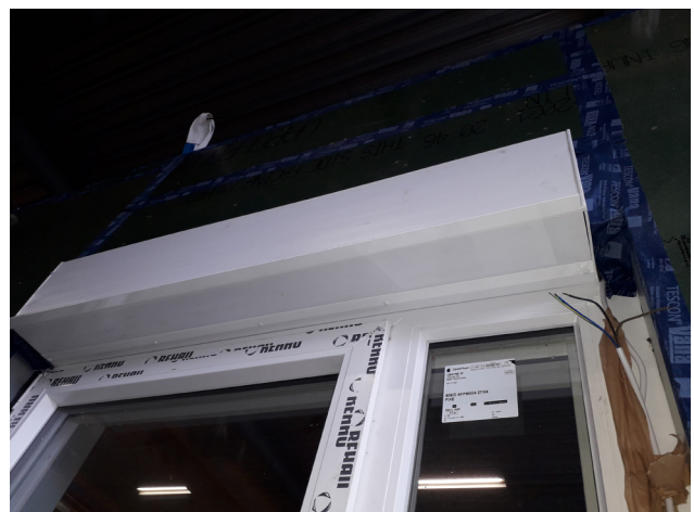
© Lorillard Vue du caisson en sous face avec adaptation réalisée pour faciliter la maintenance.
