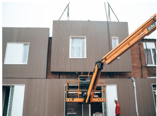
© BuildUp mise en oeuvre des éléments de façade.
