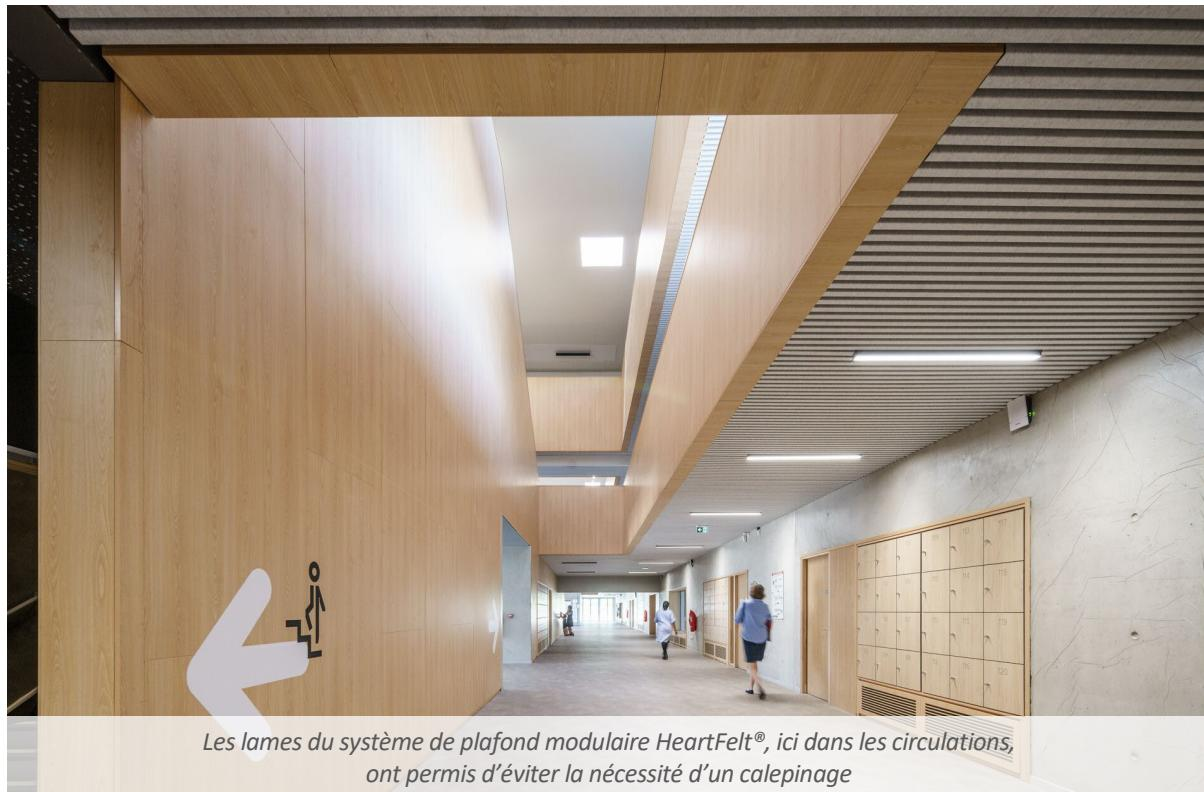
*Les lames du système de plafond modulaire HeartFelt®, ici dans les circulations, ont permis d'éviter la nécessité d'un calepinage*
