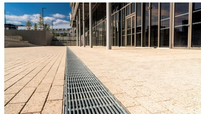
Afin d'assurer la continuité hydraulique tout en éliminant les risques de fuite, HAURATON a installé la gamme de caniveaux **EASY CONTROL®**, parfaitement adaptés pour le contrôle de l'étanchéité des bâtiments et ses particularités. Notamment en présence de portes tambour et d'espaces réduits qui nécessitent l'installation de caniveaux surbaissés spécialement conçus, ici, pour ce chantier, sans impact visuel pour les piétons.
