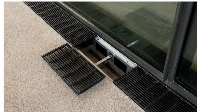
EASY CONTROL® HYDRO était donc la solution parfaite, répondant aux différentes contraintes du projet. Posé sur toute la périphérie du bâtiment, exceptée quelques zones (techniques, auvent etc...), **l'EASY CONTROL® HYDRO d'HAURATON permet le contrôle de l'étanchéité du bâtiment et le recueil des eaux résiduelles.**
