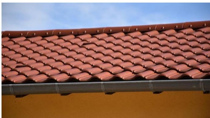
*La tuile E 58 S et une couverture en tuiles à emboîtement E 58 SL. © ERLUS*
