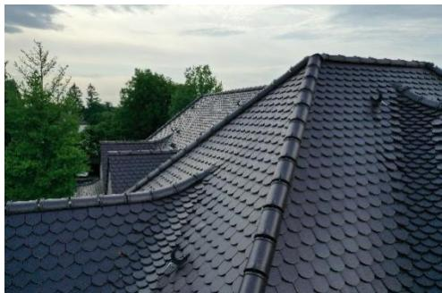
*La tuile plate écaille peut également couvrir parfaitement des toitures aux formes complexes, comme ici avec des noues et des lucarnes. Projet de référence avec tuiles Biber à découpe ronde en Brazilbraun.*
