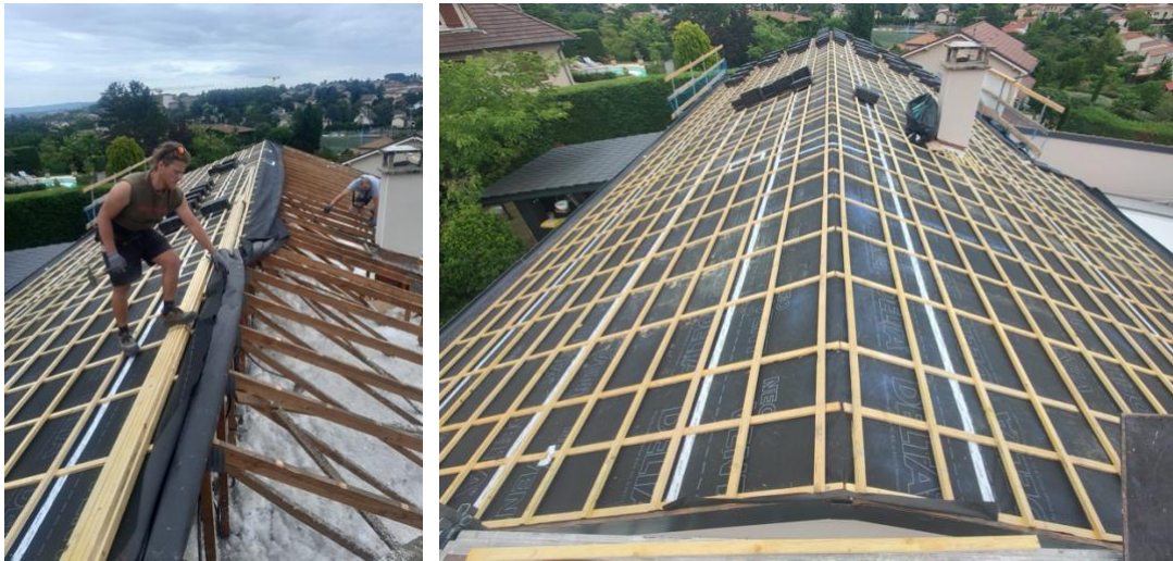
Mise en place d'un écran de sous-toiture HPV avant la pose des tuiles en terre cuite.
