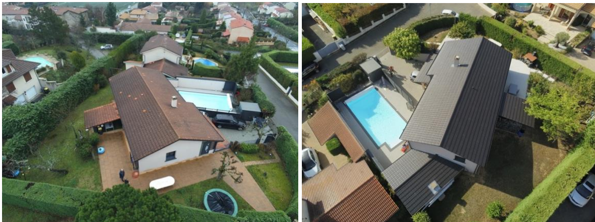
L'ancien toit couvert avec des tuiles rouges en béton La toiture rénovée avec les tuiles en terre cuite Erlus Forma Photos : Antoniali Père & Fils
