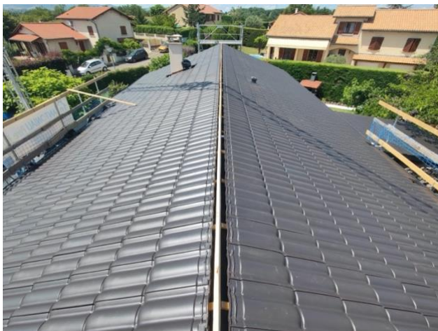
Le toit a été couvert avec la tuile Forma d'Erlus sur une surface de 237 m 2 . Photo : Antoniali Père & Fils
