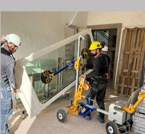
©Daucalis - pose avec exosquelette et chariot de levage
