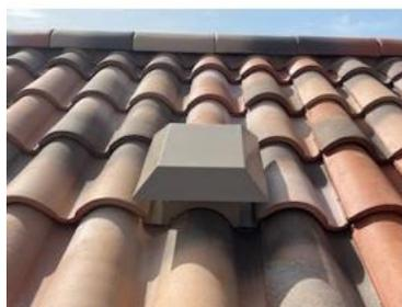
TERREAL présentera sur le stand sa nouvelle solution lancée cette année, la tuile à douille métallique adaptée aux VMC Ø 160. Elle répond **aux nouvelles réglementations RE2020** qui imposent des tests de perte de charge sur les réseaux de VMC. Avec seulement 3 Pa de perte de charge statique à 200 m<sup>3</sup>/h, cela en fait une des solutions les plus performantes du marché.
