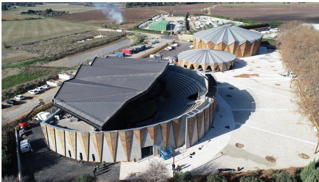
Amphithéâtre de plein air situé à Béziers (34). Charpente métallique, passerelle scénique suspendue et couverture réalisées par Scop Cabrol
