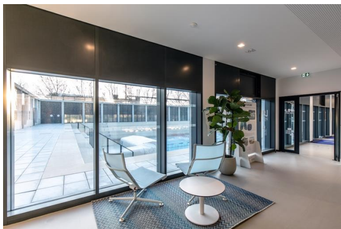
Rénovation extension du centre sportif et nautique de Gerland – LOU Rugby (Lyon 69). Installation de portes pare-flammes WICSTYLE 65 FP E30 dans le bâtiment ouest abritant la piscine d'apprentissage et les locaux techniques. Crédit photo : Patrick Loubet.
