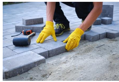
Pose de pavés en béton préfabriqué
