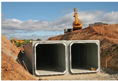
Cadres préfabriqués en béton à section variable
