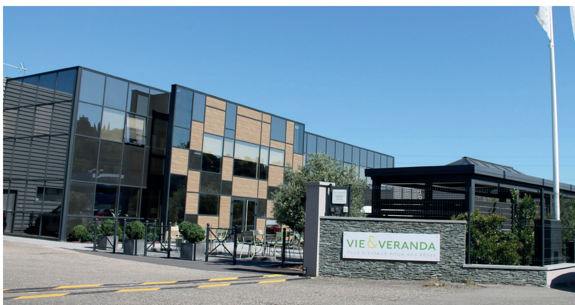
Siège de Vie & Véranda à Feyzin (69)
