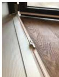
**Le nouveau seuil VEKA 3.0** est une solution **PMR à rupture de pont thermique**, conçue pour répondre aux normes d'accessibilité quelles que soient les configurations, tout en assurant une finition soignée et esthétique. Fruit de l'évolution des systèmes précédents, cette nouvelle solution **sous DTA gamme 70 VEKA** gagne en industrialisation et en flexibilité. Ainsi, le seuil VEKA 3.0 est disponible en 6 largeurs et compatibles avec les profilés 70 mm VEKA et les gâches du
