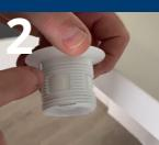
Désoperculez les lanternes pour adapter un trop-plein et installez la bonde sur l'orifice
