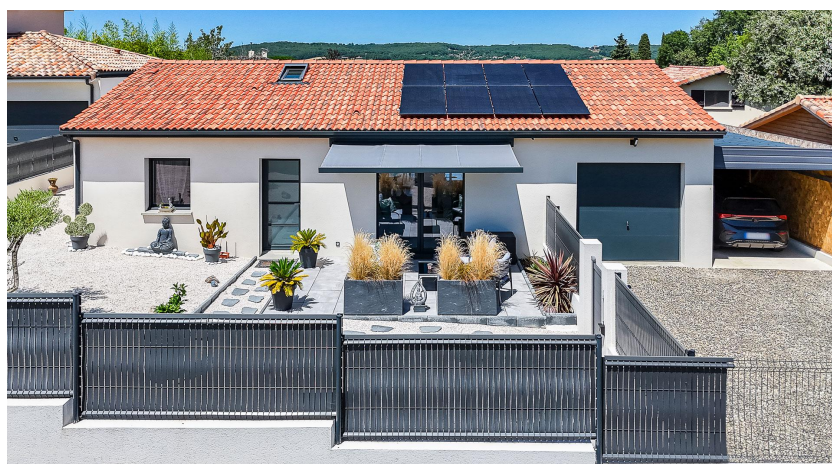
[Nestorwatt] Panneaux photovoltaïques sur toiture tuile
