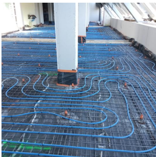
Tubes PEXc Ecotube DN16 de Thermacome posés sur le treillis
