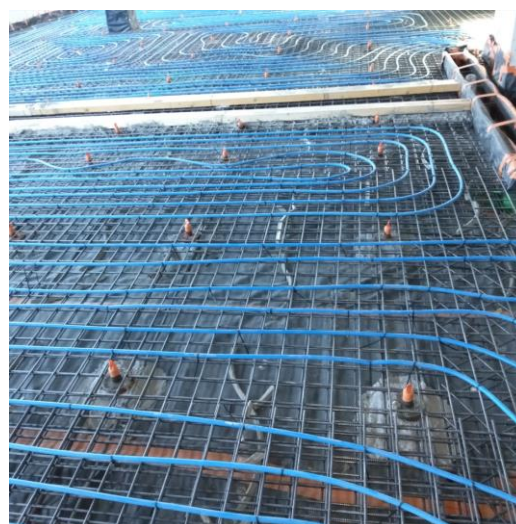
Tubes PEXc Ecotube DN16 de Thermacome posés sur le treillis
