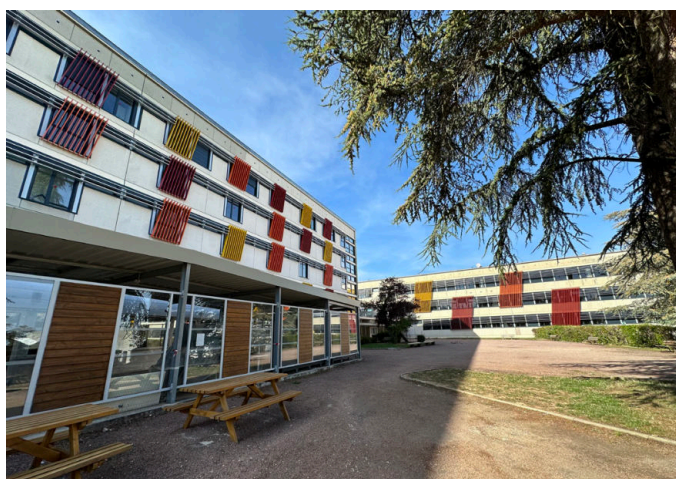
Les brise-soleil architecturaux RECTI'LIGNE de TELLIER BRISE-SOLEIL : une solution de rafraîchissement passif mis en œuvre sur les façades du Lycée des Marcs d'Or à Dijon (21). © TELLIER BRISE-SOLEIL
