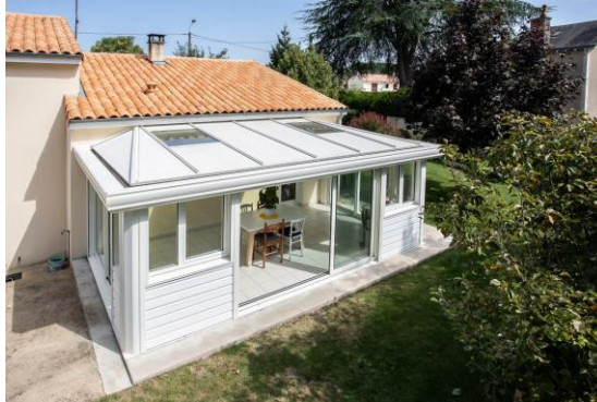
Puits de lumière © SOKO - F. Pieau
