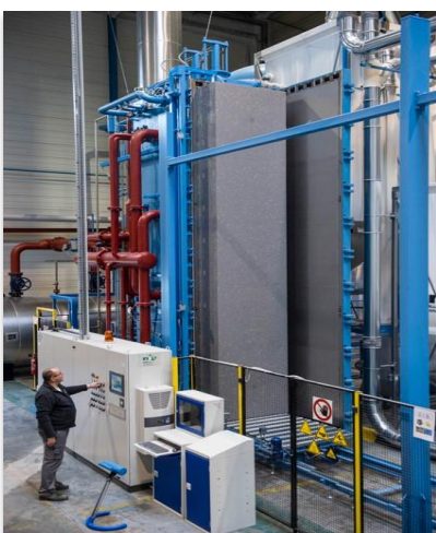
Moulage des blocs PSE
