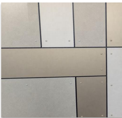
StoVentec FibreCement : nouvelle possibilité de finition sur les parois à ossature bois
