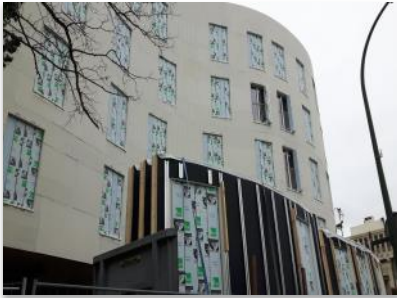
L'industrialisation des murs cintrés en ossature bois a été poussée au maximum en intégrant en usine les 600 menuiseries, leurs volets et leurs garde-corps. Crédit photo : Manuel Panaget
