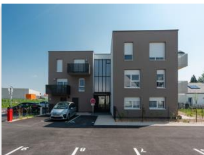
L'éco quartier Libération à Lunéville (54) L'ITE est la solution retenue pour assurer une haute isolation à l'immeuble collectif par l'équipe lauréate du dialogue compétitif, conduite par Eiffage Construction Lorraine. Crédit photo : Grégory Tachet
