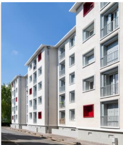
La résidence due la Saussaie à Thiais (94) APRÈS : Pour donner une image plus contemporaine au bâtiment, l'architecte propose de réaliser une ITE revêtue d'un enduit lisse beige clair. Les fenêtres sont soulignées par des cadres en tôle d'aluminium laqué pliée de teinte grise ou, aléatoirement, de couleur rouge. Crédit photo : Manuel Panaget
