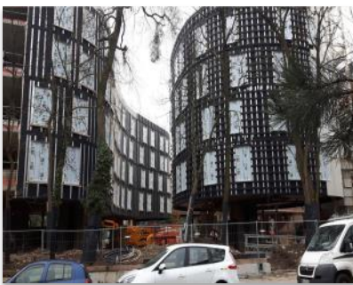
La sous-construction Sto est mise en œuvre en système mixte avec une ossature verticale métallique et une ossature horizontale cintrée en bois. Crédit photo : Manuel Panaget
