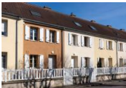
Premier chantier réalisé en StoTherm AimS ® sur fibre de bois à Pont-Sainte-Maxence, dans l'Oise.
