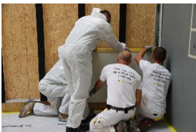
La formation « Chantier école : bardage ventilé »
