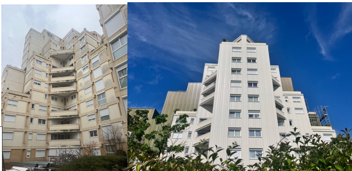
La copropriété « Le Logis vert » avant et après les travaux
