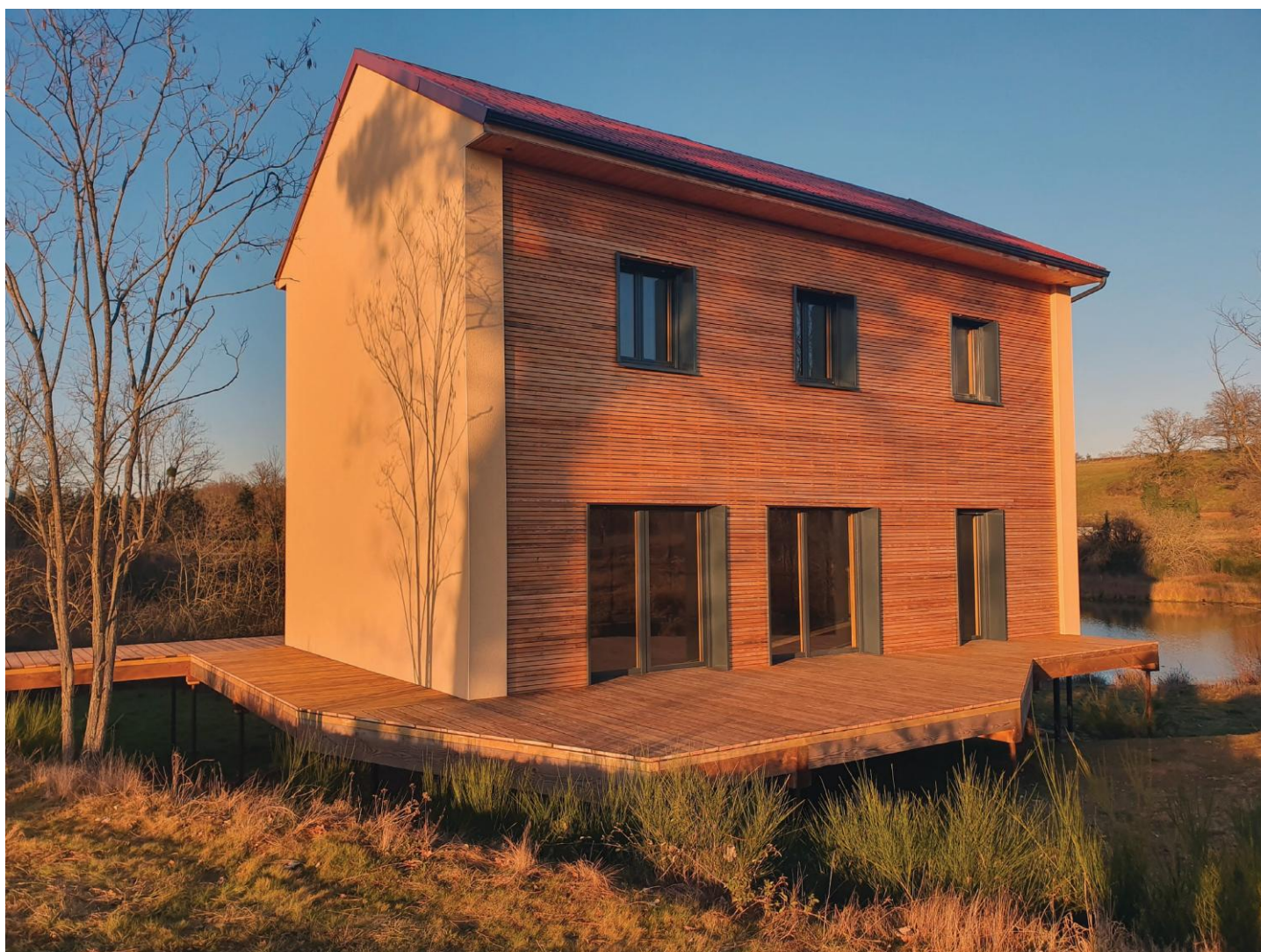
Ci-dessus, une maison individuelle signée Activ'Home, entièrement réalisée en bois/paille.
