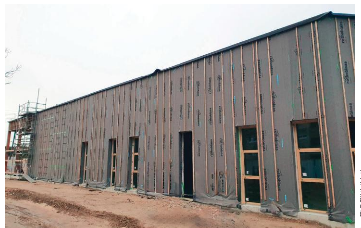
Façade à ossature bois-paille d'une extension d'usine L'Oréal SICOS dans le Nord (3500 m 2 ) pour le stockage et le laboratoire R&D. Un bâtiment à énergie positive (Architecte-urbaniste : Jean Luc Collet).
