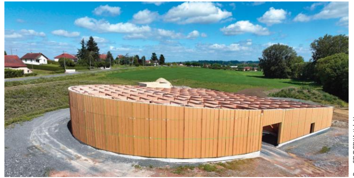
Ci-contre à droite et ci-dessous à gauche, vues de la cave vinicole Nebout, réalisée en murs à ossature bois-paille Activ'Home (architecte Charles Coulanjon/Alice Architecture).
