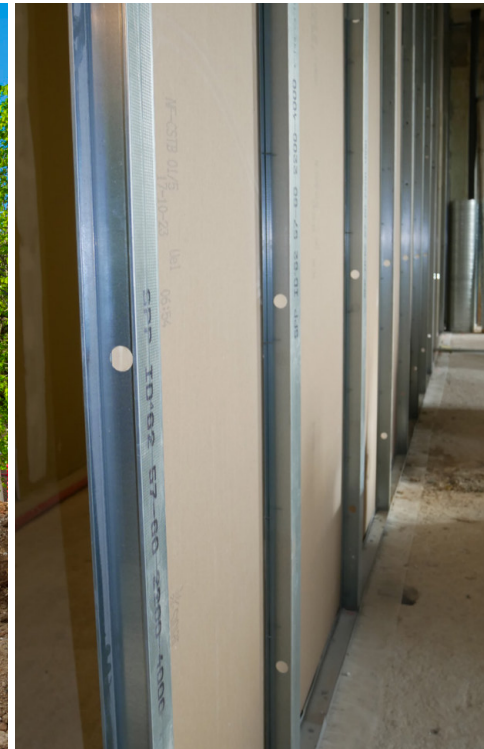
Plus de 11 500 m 2 de montants ID 4 ont été posés sur ce chantier d'envergure.
