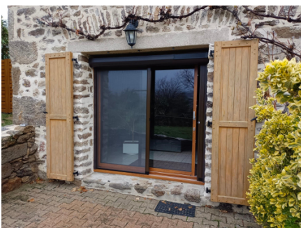
Rénovation d'une baie vitrée coulissante en aluminium avec moustiquaire latérale et volet roulant solaire
