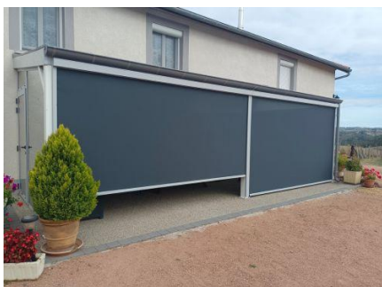
Pose de stores ZIP motorisés
